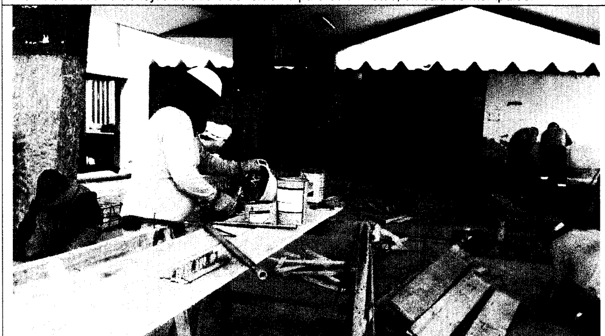
Imagen N° 02: En la presente imagen se puede observar el uso de aditivo Sikadur 31 para anclaje de acero de refuerzo en sobrecimiento en sala de manipuleo.
